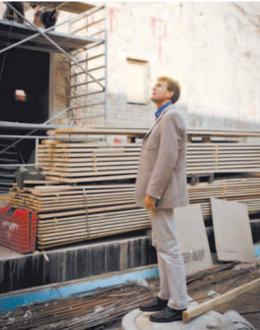
Museumsdirektor Dr. Michael Schmitz wartet schon auf die Baustellenparty Anfang Januar am Naturhistorischen Museum
